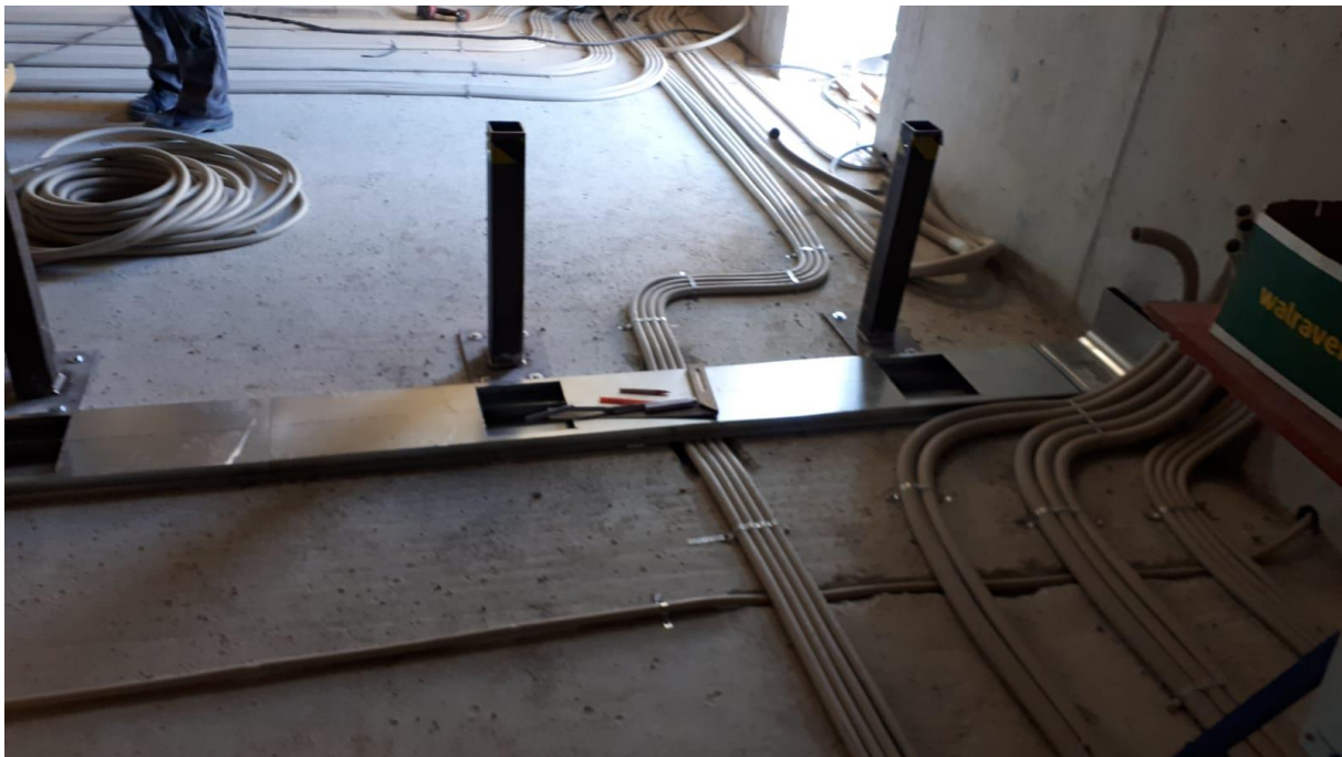
Der Kabelkanal wird verlegt.
